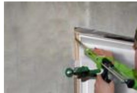
FM790 für die punktuelle Befestigung von Innen-Tür-Zargen und Holztürfuttern.
