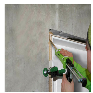
2. Bild: FM790 für die punktuelle Befestigung von Innen-Tür-Zargen und Holztürfuttern.
