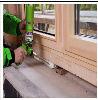
1. Bild: Verarbeitung der Fensteranschlussfuge mit FM220.
